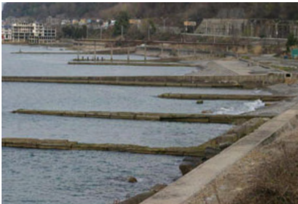
Рис. 9.4. Инженерные сооружения, защищающие размыв берегов в Сочи (ресурсы Интернет)
